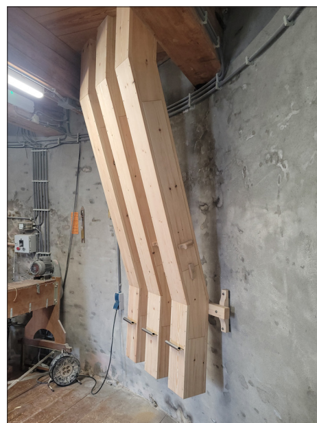
De pijpen van de steenzolder naar de maalzolder
