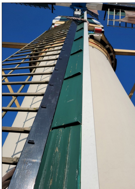
Links de hek- en zoomlatten, rechts de windborden en voorzoom
