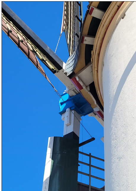
Zeilarm voor het ophangen van de molenzeilen aan de volgende wijk.
