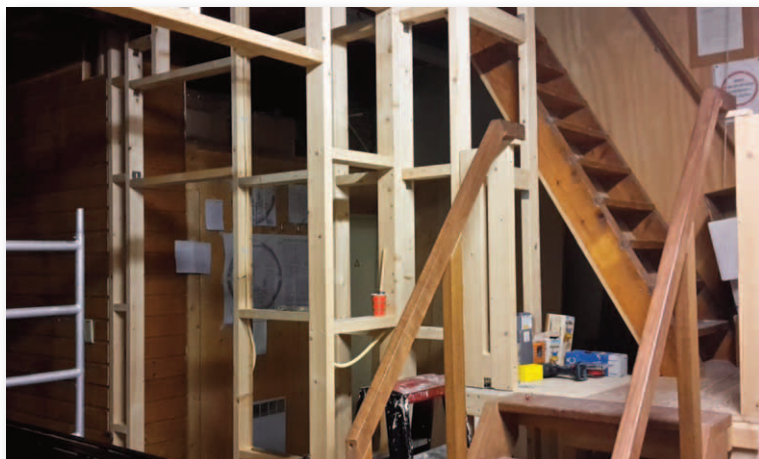
Het slopen is gebeurd en het opbouwen is begonnen
